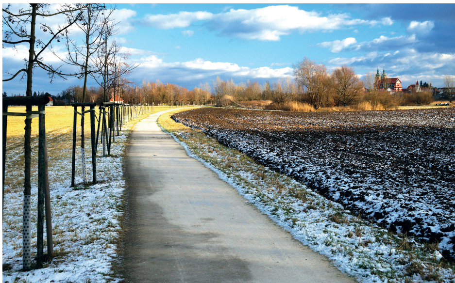
Nově vybudovaná cesta s doprovodnou zelení
