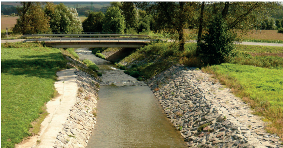
Zpevnění břehů koryta vodního toku
