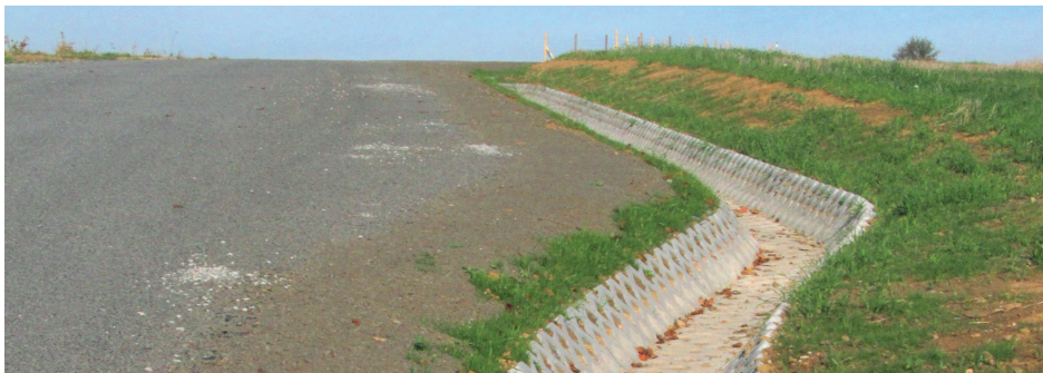
Zpevněná cesta s příkopem
