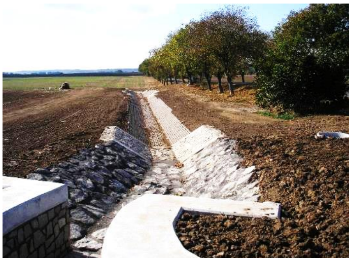
Obr. 9. P 1 – zpevněný začátek obtokového kanálu
