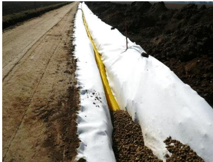
Obr. 4. Odvodnění polní cesty C-2, drenáž DN 160
