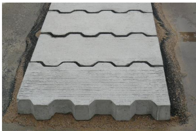
Obrázek 2: Použité prefabrikáty 800 x 330 x 120 mm
