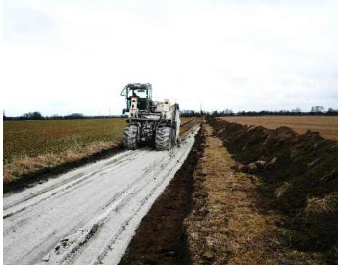
Obr. 2. Úprava zemní pláně vápennou stabilizací
