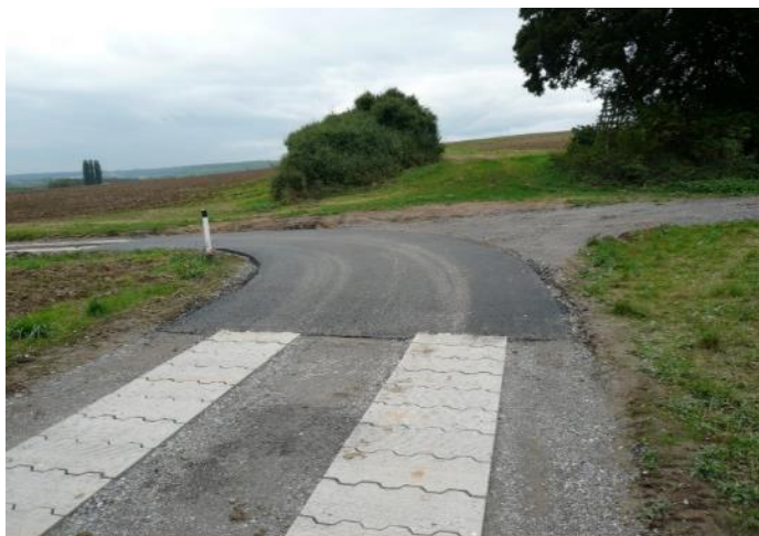
Obrázek 6: Řešení ostré zatáčky pomocí asfaltového betonu
