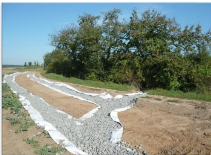
Obr. 2. Výstavba hlavní polní cesty C 15 a zaústění drénů do biocentra ŽP 1
