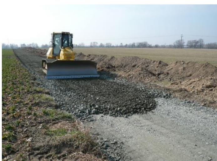
Obr. 6. Pokládání štěrkových vrstev
