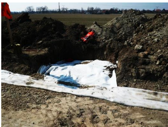
Obr. 5. Vsakovací jámka
