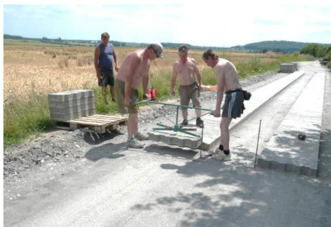
Obrázek 3: Pokládání betonových prefabrikátů
