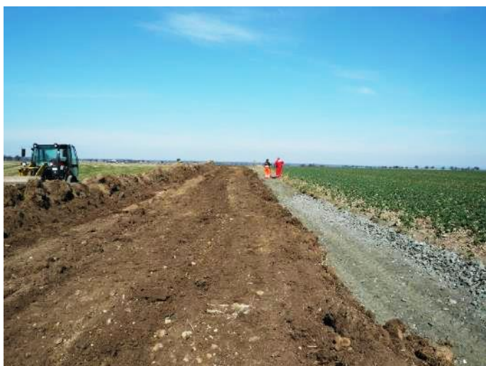
Obr. 7. Rozhrnování horní humusové vrstvy zeminy
