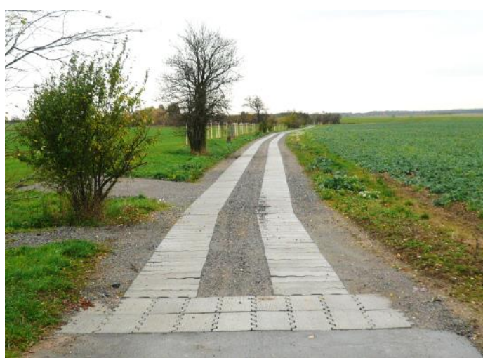
Obrázek 5: Napojení na HPC, prefabrikáty jsou uloženy napříč
