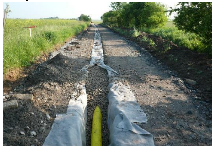
Obr. 5. Vedlejší polní cesta C 14 – umístění drénu v ose
