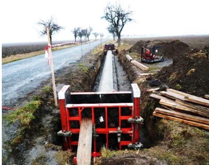
Obr. 1. Napojení PC na silnici III/32924, zatrubnění příkopu
