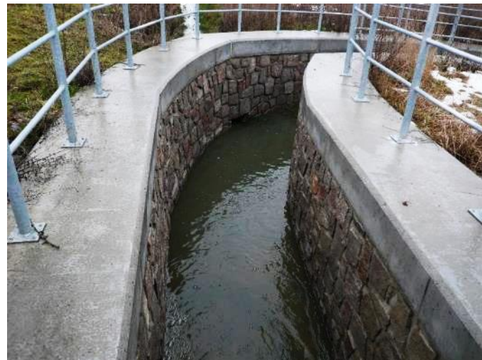
Obr. 10. Obtokový kanál P 1 – rozbočovací objekt
