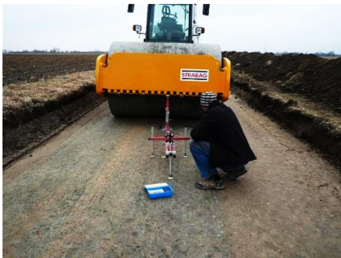
Obr. 3. Zkouška zhutnění pláň
