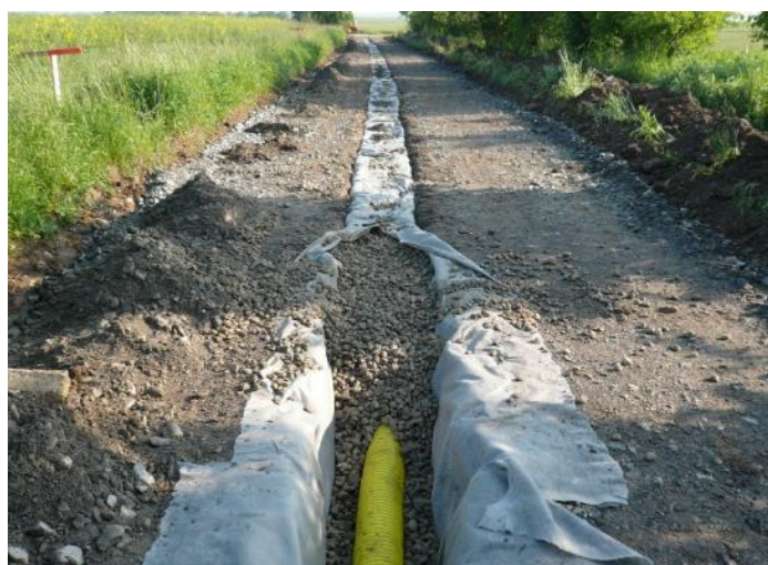
Obrázek 4: Pokládání drenáží do středu vozovky
