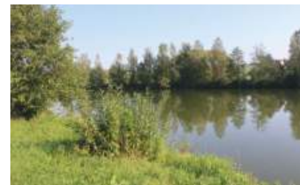
Obrázek 21: Vodní nádrž I. v k.ú. Hlohovčice, Pobočka Domažlice, KPÚ pro Plzeňský kraj. Rok realizace 2002 – 2003, celkové náklady 4 675 017 Kč, zdroj financování: Program revitalizace říčních systémů (MŽP), Obec Hlohovčice, prostředky Pozemkového úřadu Domažlice (VPS).
