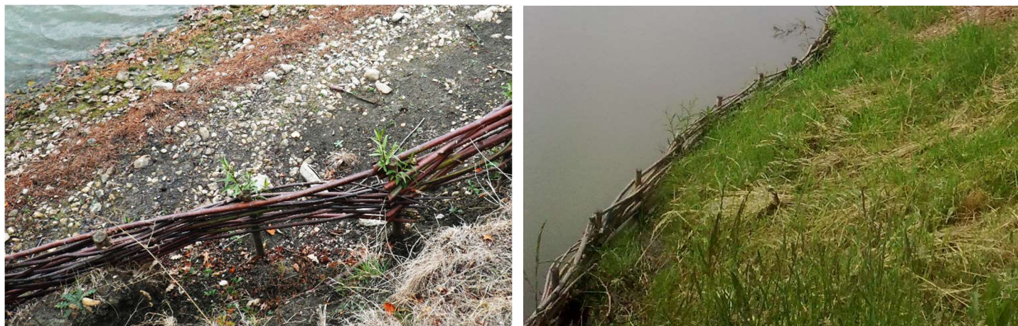
Obrázek č. 6 a 7: Zpevnění břehů rybníka haťovým plůtkem z vrby
