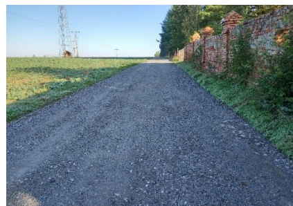
VC11 během realizace (rekonstrukce)
