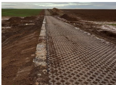
DC1 během realizace
