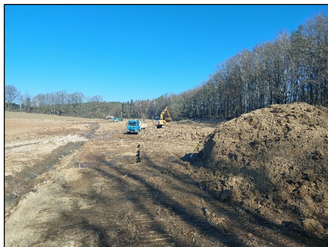
STAV V PRŮBĚHU REALIZACE:
