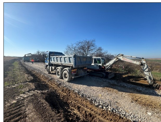
Pokládka konstrukčních vrstev
