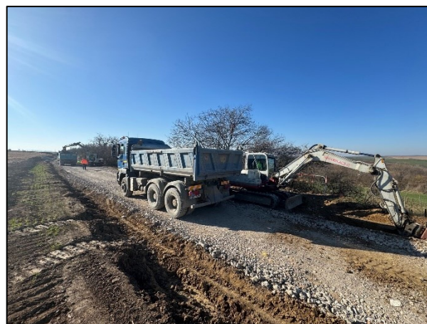
Pokládání štěrkových vrstev
